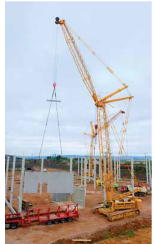
Insg. werden 1.309 Betonteile mit einem Gesamtgewicht von 9.700 t mit den beiden Raupenkranen verbaut.
