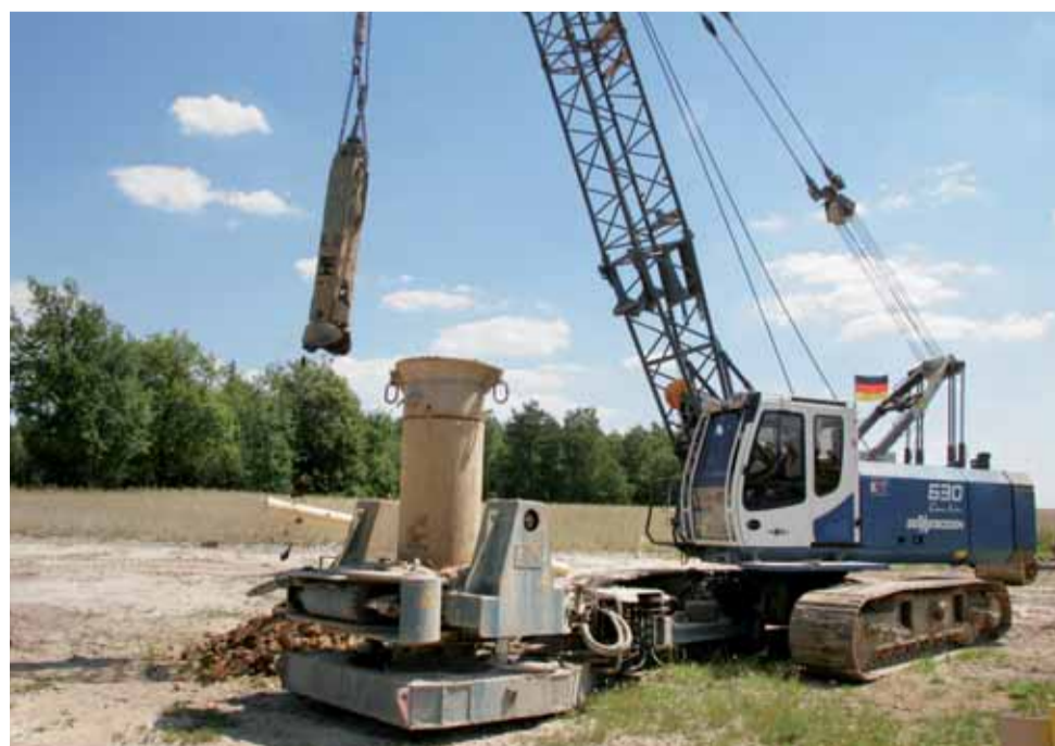
Mit dem SENNEBOGEN 630 HD werden auf einem Streckenabschnitt von 136 km ca. 1.000 Brunnen mit einer Tiefe von 6 bis 10 m gebohrt.
