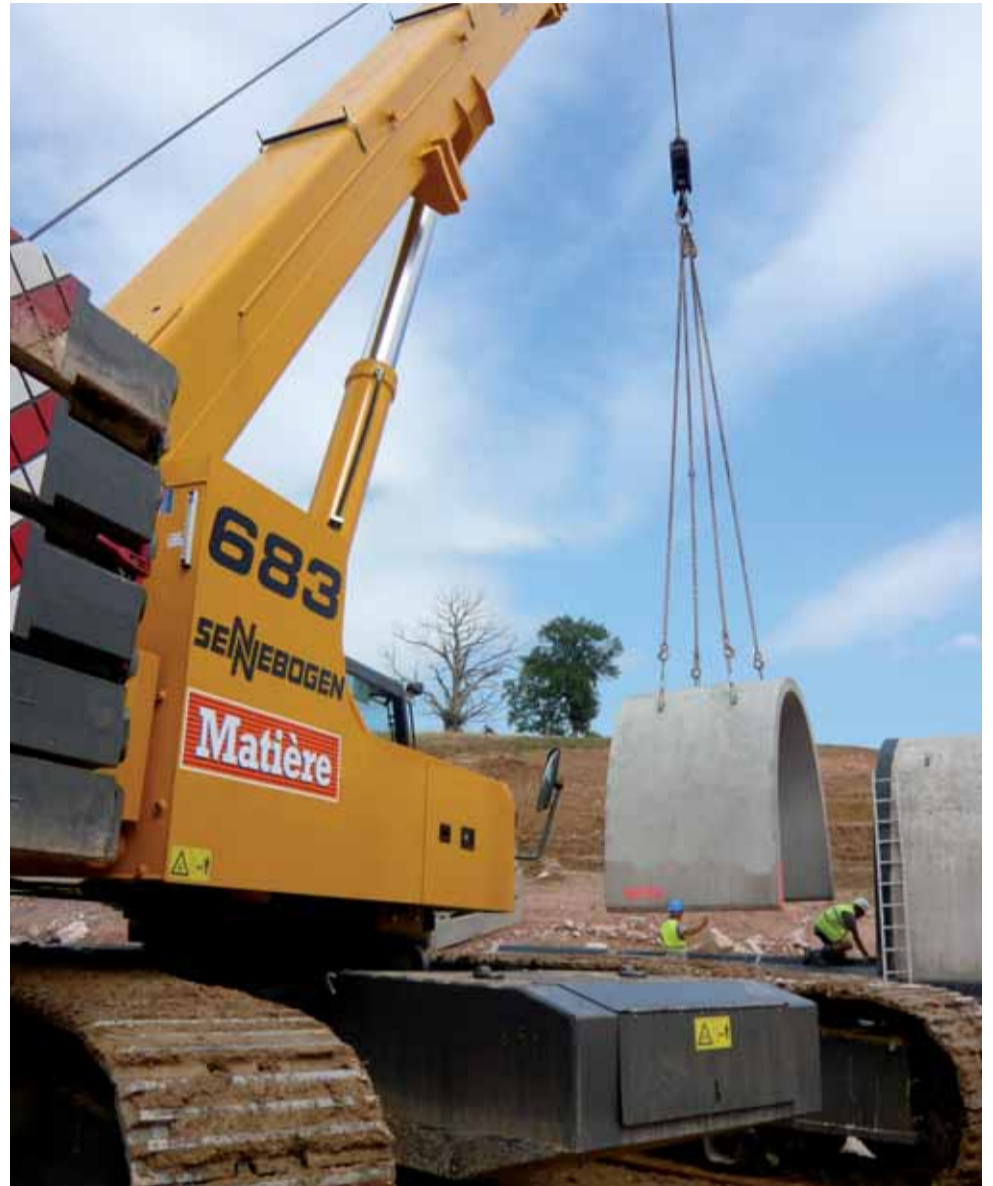
Optimal für die Montage der bis zu 25 t schweren Fertigbetonteile. Für das sichere Heben, Verfahren und Positionieren unter Last ist der SENNEBOGEN 683 Raupen-Teleskopkran ideal.
