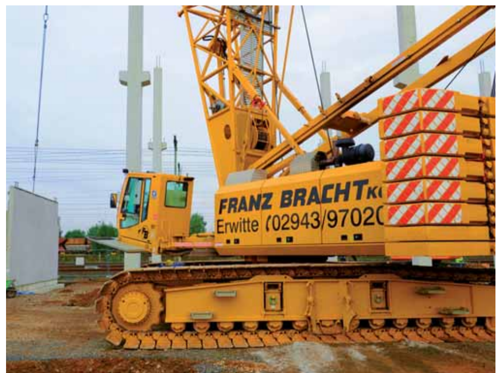
Das Verfahren unter Last ist auch bei dieser Baustelle ein großer Vorteil.
