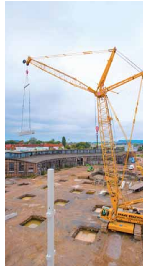
Die zwei SENNEBOGEN Raupenkrane 4400 und 5500 bei der Betonfertigteilmontage für ein neues Möbelhaus. Das Gebäude im Hintergrund ist ein denkmalgeschützter Lokschuppen, der in das Möbelhaus integriert wird.
