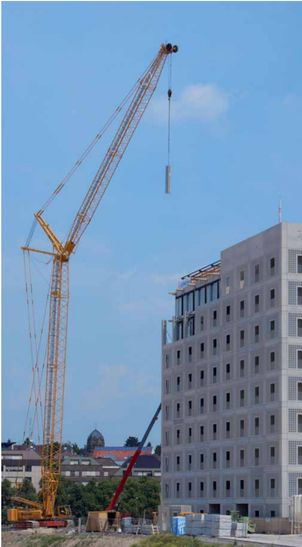
Die bis zu 15 t schweren Fassadenelemente aus Beton und Glasbausteinen wurden mit dem SENNEBOGEN 5500 präzise und sicher an die vorgesehene Stelle gehoben.
